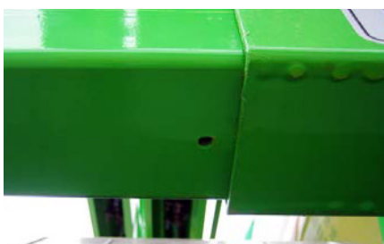
Abb. 137. Kontrollbohrung
