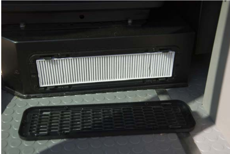
Abb. 206. Feinstaubfilter Heizungsanlage
